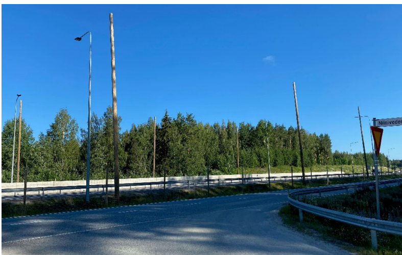
Kuva 5. Kannelsuon kaava-alueen länsipuolelle sijoittuvan valtatie 4 perusparannushankkeen yhteydessä valtatie molemmin puolin on toteutettu liito-oravan liikkumisen mahdollistavia puupylväitä. Kierälahden ranta-alueen kautta mahdollistettava liito-oravan puustoinen kulkuyhteys tukee lajin säilymistä.
