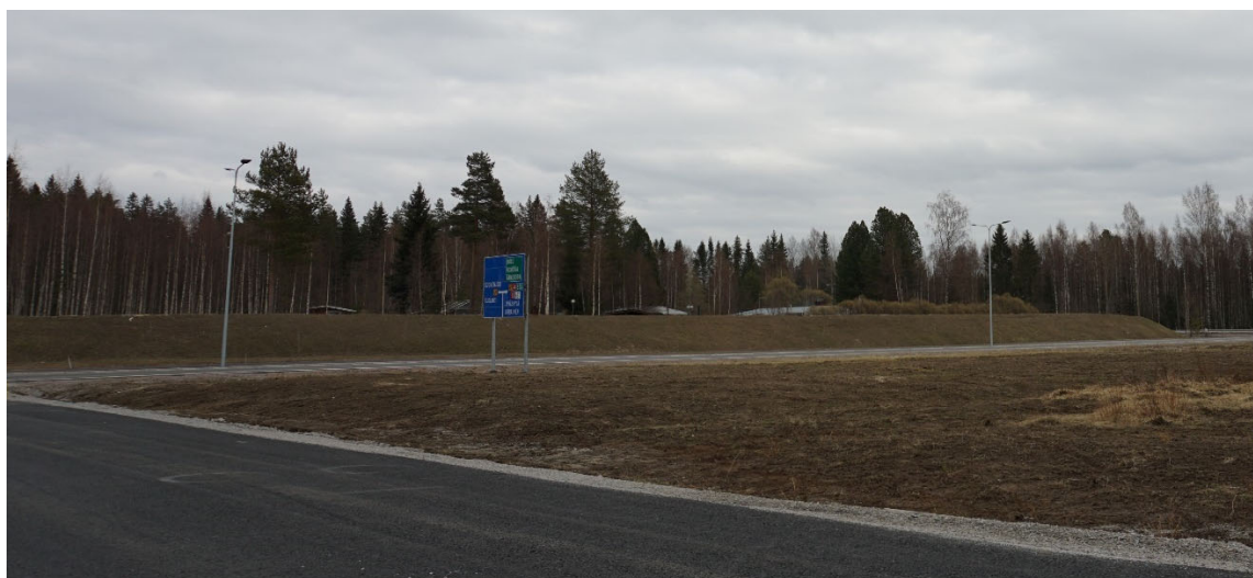
Voimassa olevassa kaavassa osoitetuille Rannankyläntien ja Hitonlahdentien varren suojaviheralueille on rakennettu meluvallit yritysalueiden ja asumisen alueiden välille.
