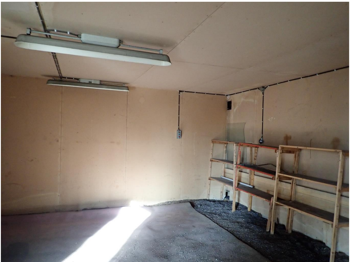
Kuva 5-6. Yksi autotallirakennuksen halleista. Nurkan yläkulmassa näkyy tuuletusaukko, joista lepakoilla olisi mahdollisesti pääsy rakennuksen sisään.
