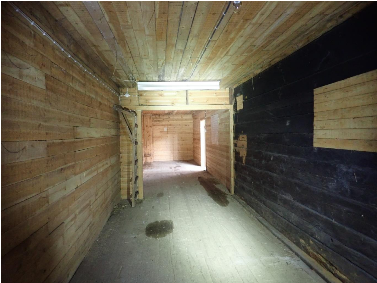
Kuva 5-7. Autotallirakennuksen takaosan pitkänomainen tila.
