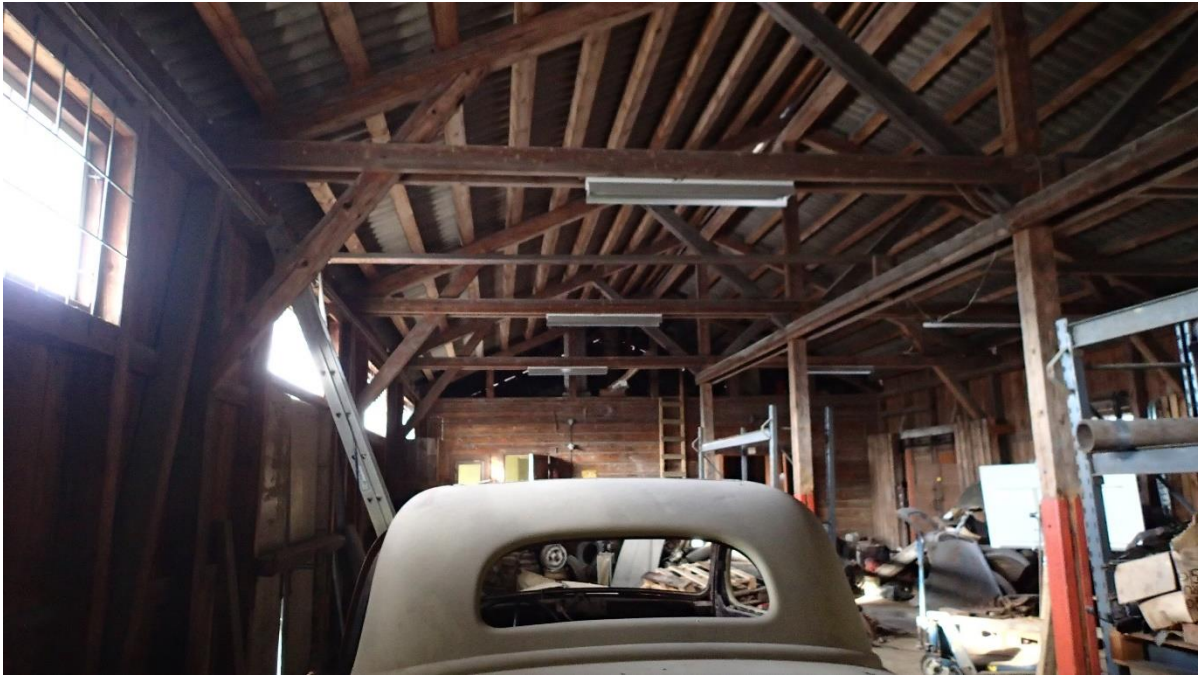
Kuva 5-16. Makasiinirakennuksen halli. Kuvassa taka-alalla näkyy parvi, jonne on käynti tikkaita pitkin.
