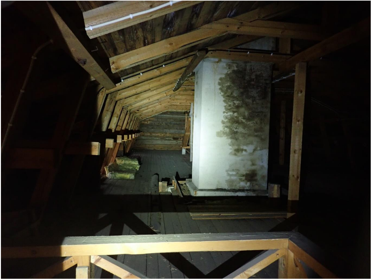
Kuva 5-12. Rautatieaseman ullakko. Kuvan keskellä olevan piipun reunoilta ja tyveltä havaittiin lepakon jätöksiä.
