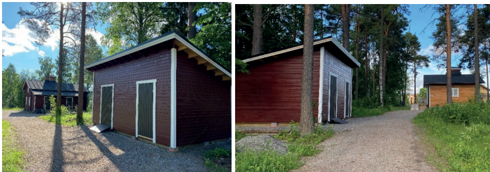
Kuva. Hiskin saunan ja Hiskin mökin välille toteutettu talousrakennus ja sorapintainen kulkuväylä.
