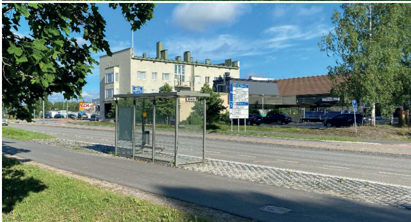
Bussipysäkin katos ja sen rakennettua ympäristöä. Suolahden suuntaan menevän ajoradan ja kevyen liikenteen väylän väliin on toteutettu viherkaista. Suolahden suunnasta tuleva kevyen liikenteen väylä on toteutettu korotettuna ajoradan viereen.
