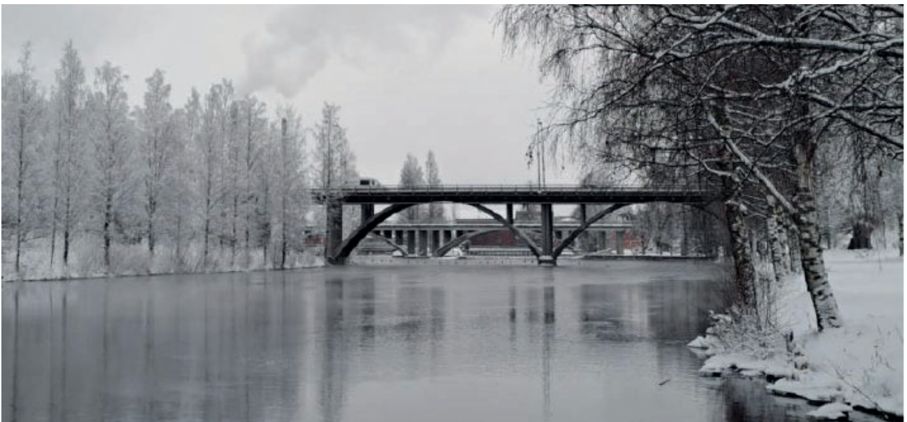
Kuva. Purettava Äänekosken silta kuvattuna pohjoisen suunnasta. Taustalla näkyy tehdasalueen rautatiesilta. (Maisemaselvitys, Afrý).
