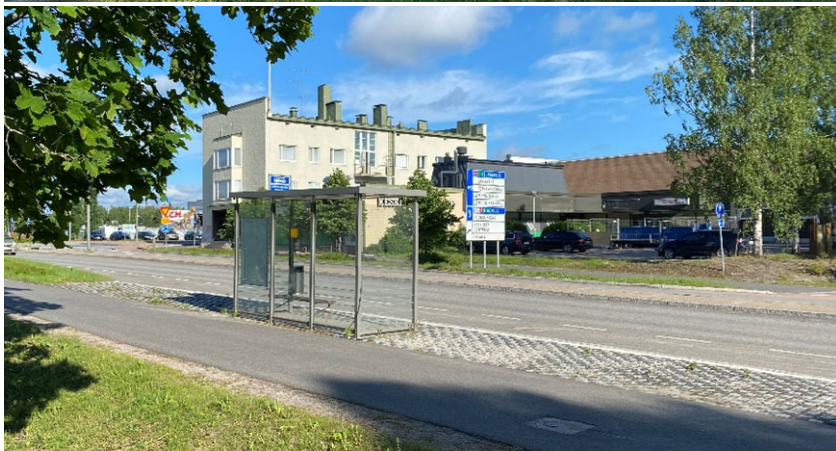
Bussipysäkin katos ja sen rakennettu ympäristöä. Suolahden suuntaan menevän ajoradan ja kevyen liikenteen väylän väliin on toteutettu viherkaista. Suolahden suunnasta tuleva kevyen liikenteen väylä on toteutettu korotettuna ajoradan viereen.
