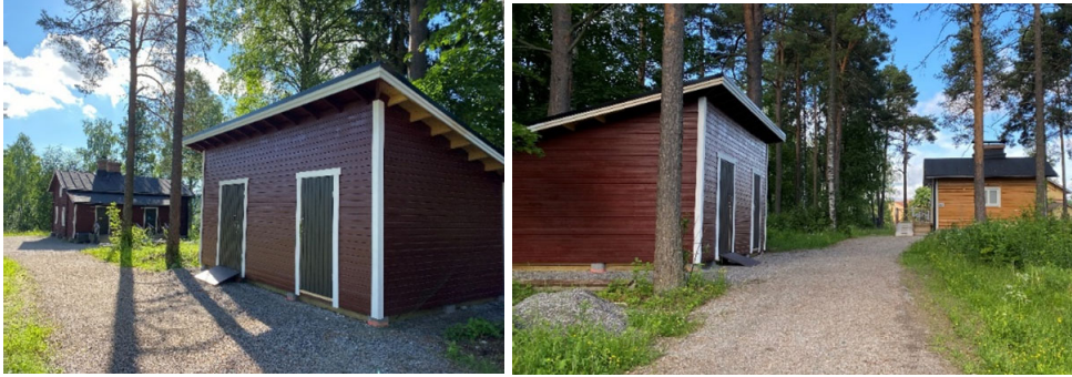
Kuva. Hiskin saunan ja Hiskin mökin välille toteutettu talousrakennus ja sorapintainen kulkuväylä.
