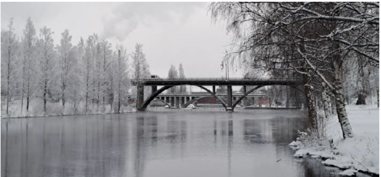
Kuva. Purettava Äänekosken silta kuvattuna pohjoisen suunnasta. Taustalla näkyy tehdasalueen rautatiesilta. (Maisemaselvitys, Afrý).
