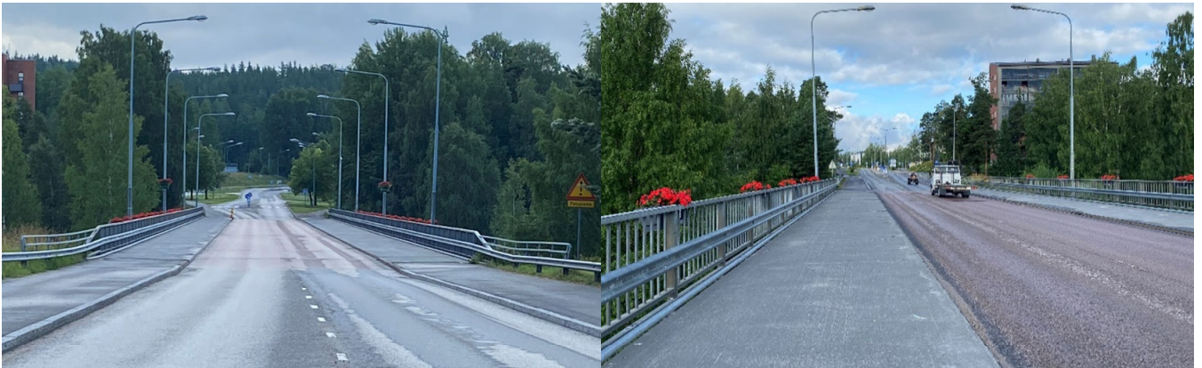
Kuva. Nykyinen Äänekosken silta idän ja lännen suuntaan kuvattuna. Uusi silta toteutetaan sillan eteläpuolelle.
