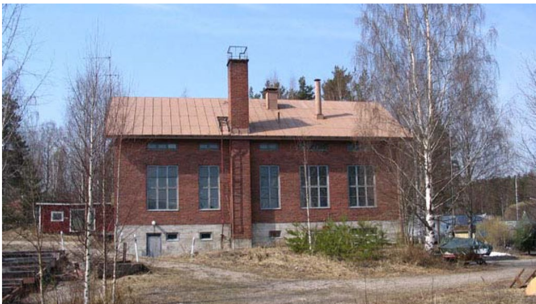
Kuva. Satamarakennus vuonna 2006 (Rakennusinventointi 2006, kohdekortti 226, Keski-Suomen museo / Juuso Väisänen, Päivi Andersson).
