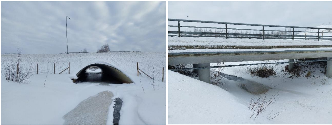
Kuva 9-4. Valtatie 4 alittava rumputunneli tien länsipuolelta kuvattuna (vas) ja Rannankyläntien sillan alittava osuus Kuorejoesta (oik).
