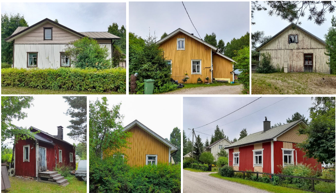
Kuva 25. Höökinkadun harjakattoisia rakennuksia 1900-luvun alkuvuosikymmeniltä.
