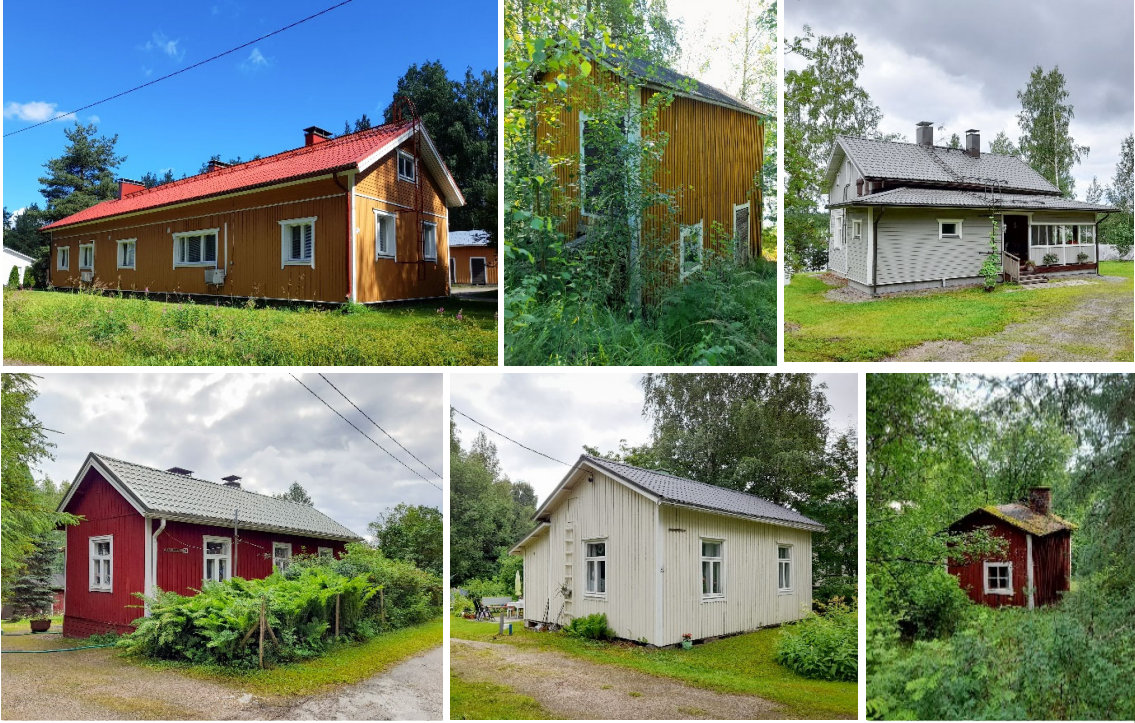
Kuva 19. Majalankadun vanhimpia rakennuksia 1900-luvun alkuvuosikymmeniltä. Ylhäällä vasemmalla entinen sahan vuokra-asuintalo Mäkinen, jonka vieressä vanha rantaan rakennettu puusepäntorppa. Harmaa "Kankaisten talo" on yksi rungotaan vanhimmista asuinrakennuksista. Alla asuinrakennuksia ja saunamökki.
