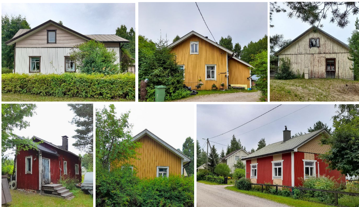
Kuva 25. Höökinkadun harjakattoisia rakennuksia 1900-luvun alkuvuosikymmeniltä.
