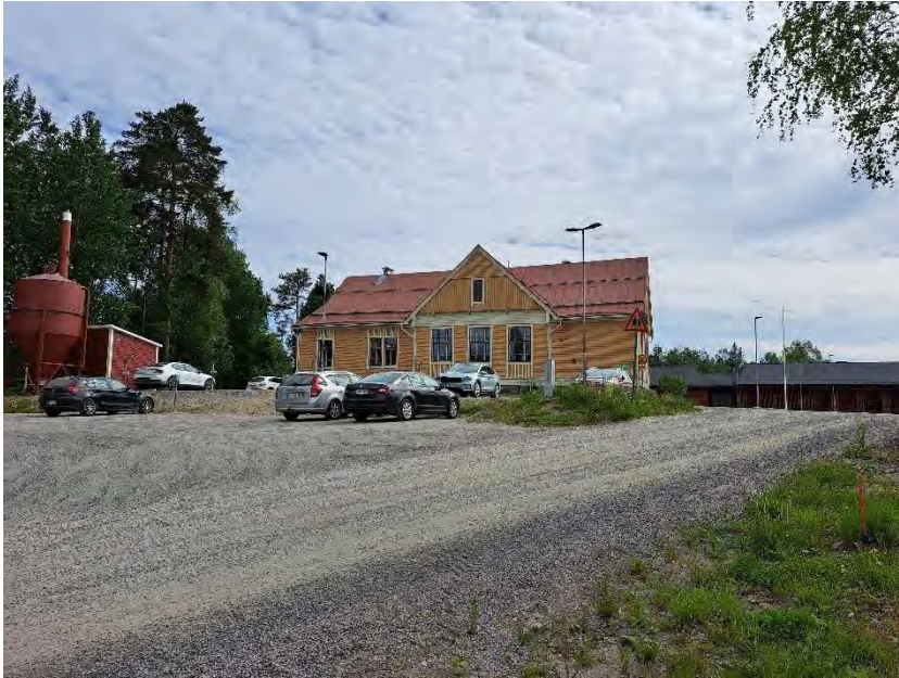
Kuva 6. Vanhakoulu edustalla ja uusi rakennus taustalla.
