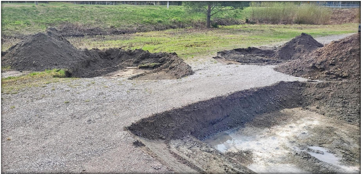
Kuva 4-2. Piha-alueella sijainneen huoltoaseman ja sen mittarialueen perustukset ovat paikoillaan.
