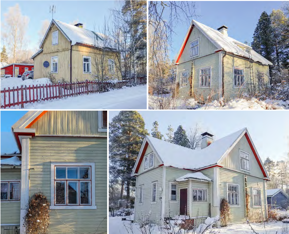
Kuva 13. Vesimiehenkatu 7 on keltaiseksi maalattu alkuperäiseltä pohjaltaan kaksihuoneinen pientalo, jota on laajennettu myöhemmin kuistiosin. Runeberginkatu 15 on ulkoisesti hyvin alkuperäisenä säilynyt pohjaltaan nelihuoneinen asuinrakennus, jonka pihan puolella on laaja poikkipäädyn muodostava kuistiosa. Kuistin molemmilla puolilla on umpinaiset sisäänkäyntikatokset peilikuvan tapaan joista toisesta on ollut käynti ullakon asuntoon tai huonetiloihin. Huomattavaa rakennuksessa on suuret ja alkuperäiset 4-lasiset ikkunat tai ”tuvanikkunat” rakennuksen kaikilla kolmella sivulla sekä satulakaton päädyissä.
