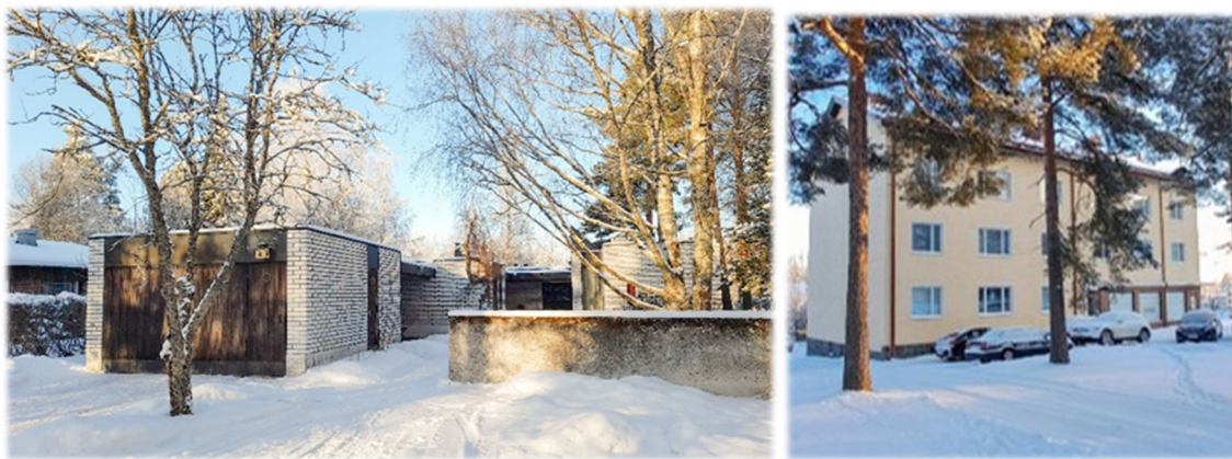
Kuvia. Talo Piirilä ja Kotakennäätie 13. Inventointi suosittelee rakennuksille suojelua sr-merkinnällä (Rakennusinventoinnin tausta-aineisto 2026, Äänekosken kaupunki).
