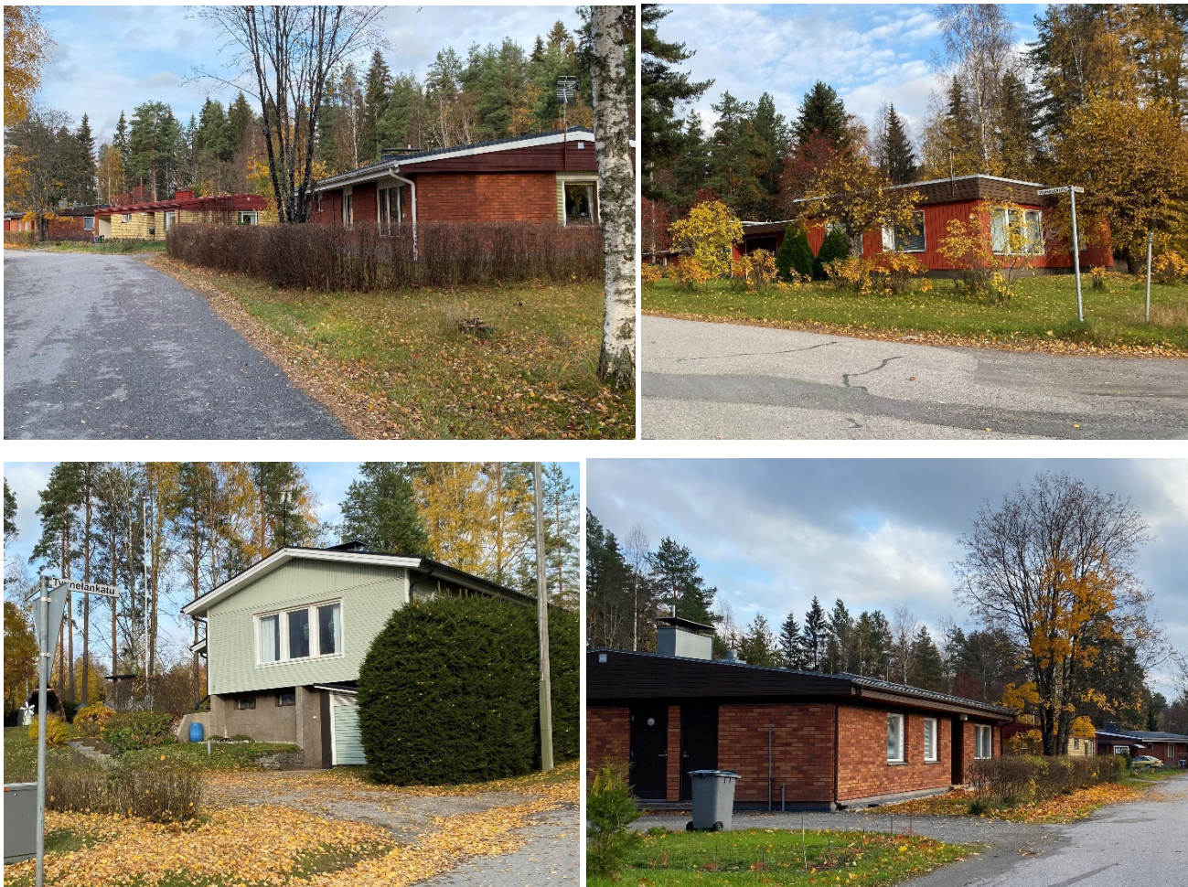
Kuva 14. Rakennuskantaa Tyynelänkadun ja Hannulantien varrella.
