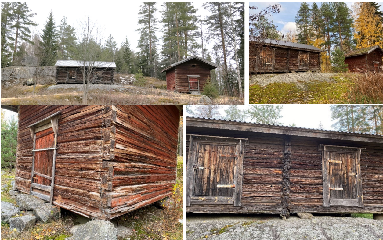
Kuva 18. Tallilan aitat. Aitat sijoittuvat kallioiselle alueelle kiviperustuksin.
