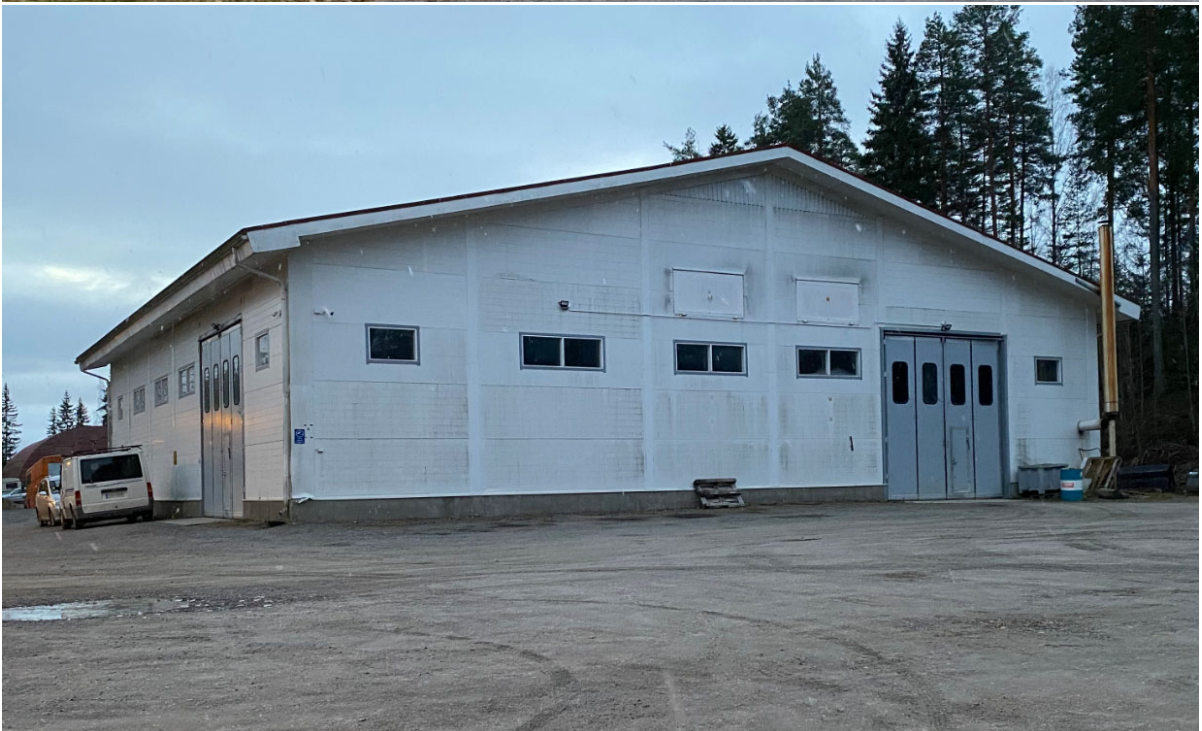
Kuvia. Teollisuuskadun varrelle toteutettua rakennuskantaa. Alueella on neljä varistorakennusta/hallia.
