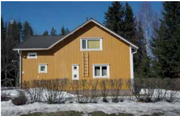
Kuvia. Tiesuunnitelmien ja kaavamuutoksen myötä poistuvia asuinrakennuksia. (Äänekosken kaupunki & Google)
