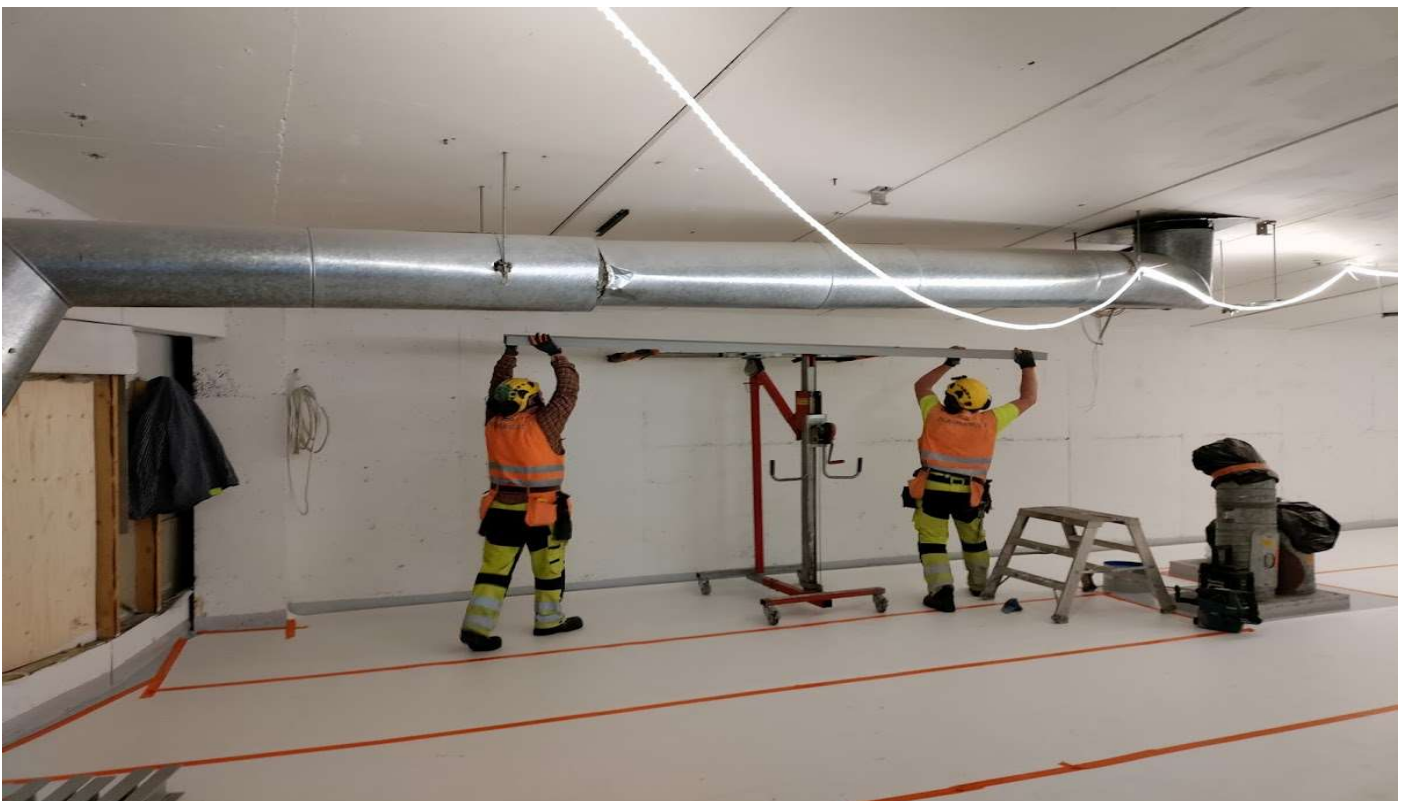
Juki ja Arttu asentaa tukirautoja IV konehuoneen kattoon.
