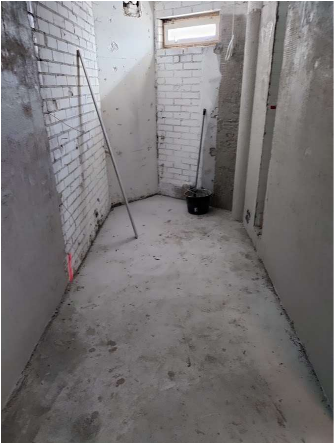
Pesuhuoneen ja saunan lattiavalut tehty. Seinien tasoitukset käynnissä.
