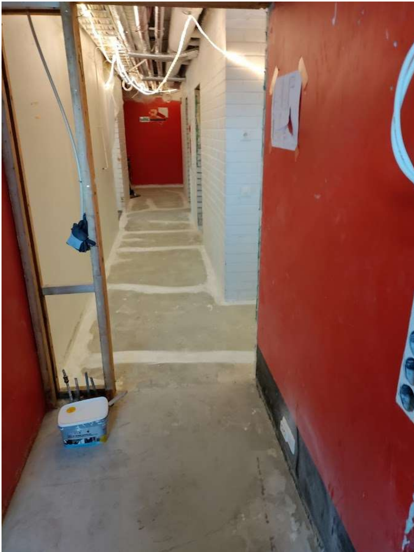
Pohjakerroksen maanvaraisen laatan tiivistyksen työnalla.
