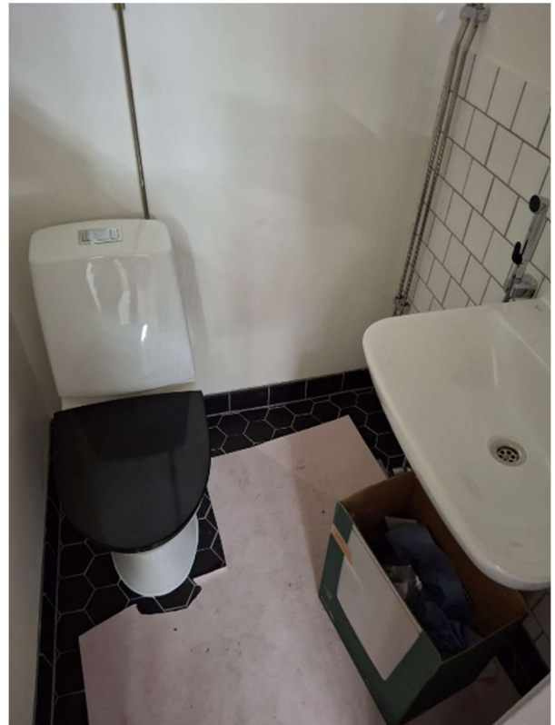
Ensimmäisen kerroksen WC-tiloissa on asennettu vesikalusteet. Seuraavaksi loput varusteet ja sähköasennukset.
