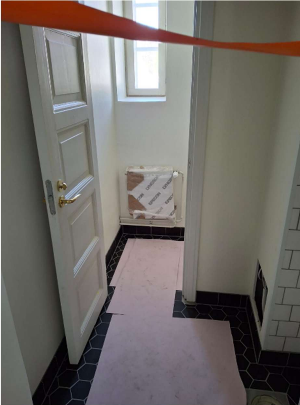
Laatoitukset valmiit 2. krs WC- ja siivoustiloissa. Seuraavaksi vesikalusteiden asennusta.
