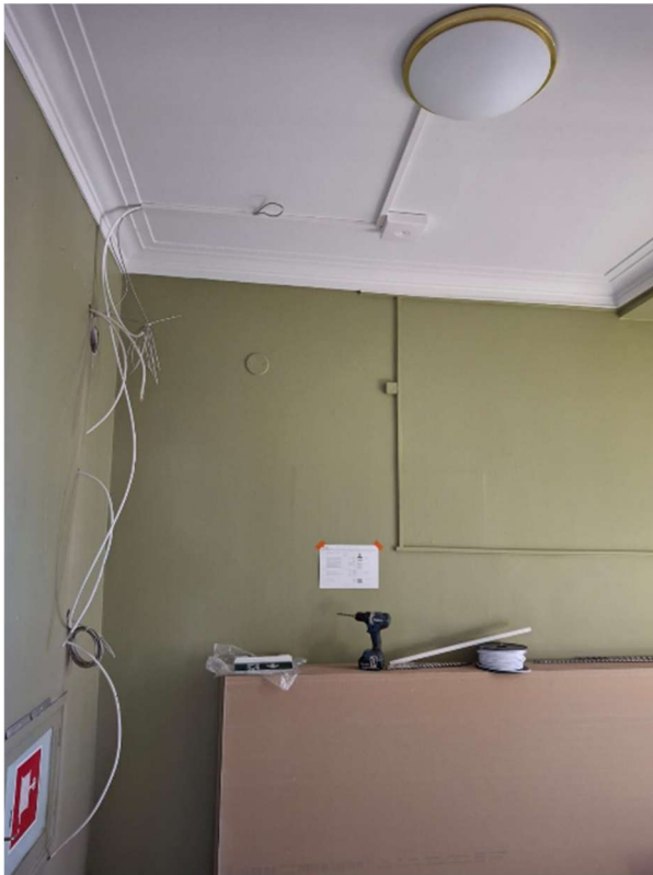
Sähköasennukset aloitettu porrashuoneissa.
