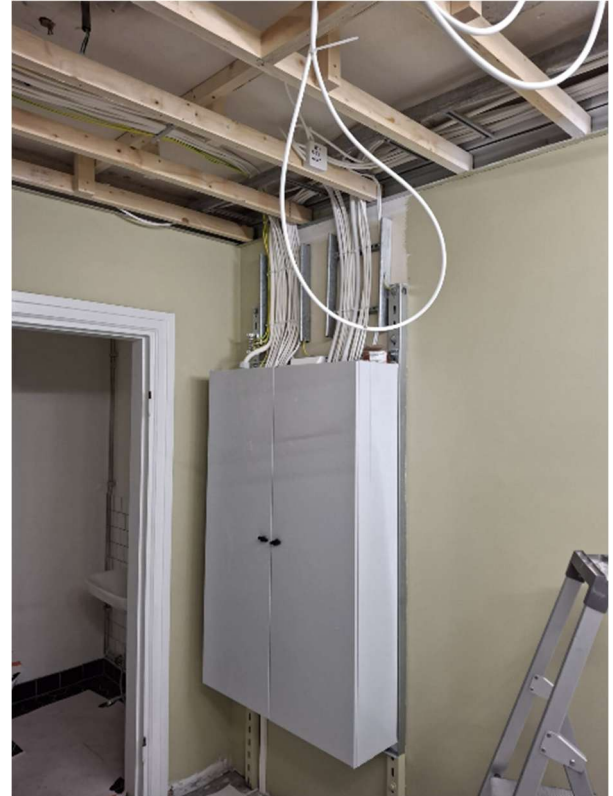
Sähköasennukset jatkuvat työmaalla.
