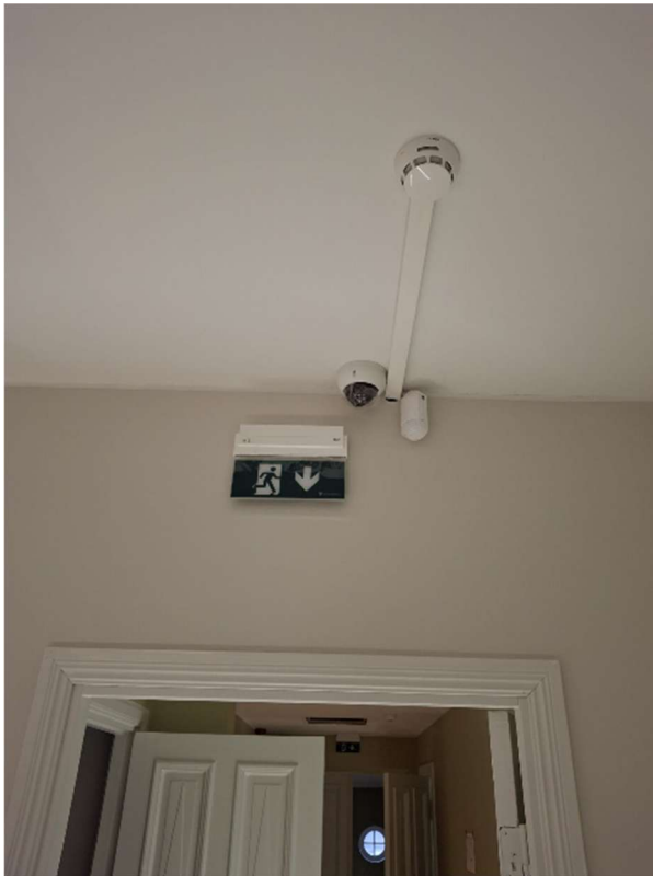
Turvalaiteasennukset käynnissä työmaalla.
