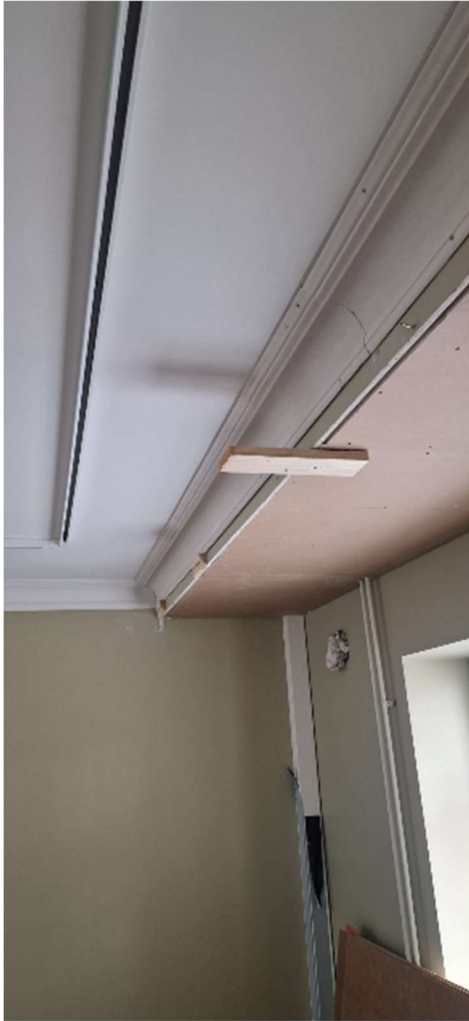
Koristeellisen kattofriisin asennusta eteisaulaan. Friisi on valettu kipsistä.
