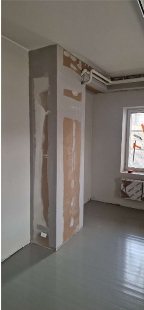
Tekniikkakotelo tasoitettuna ja pohjamaalia vailla.
