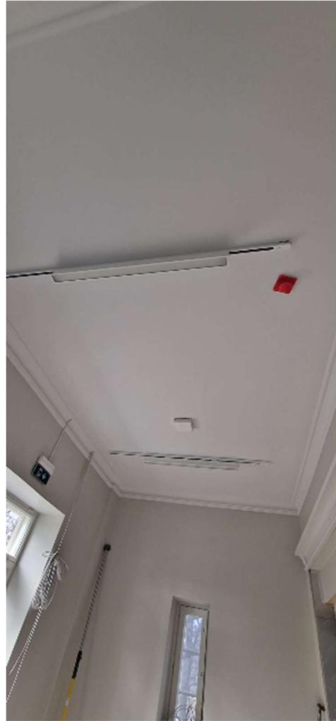
Valaisimia on asennettu kattoon.
