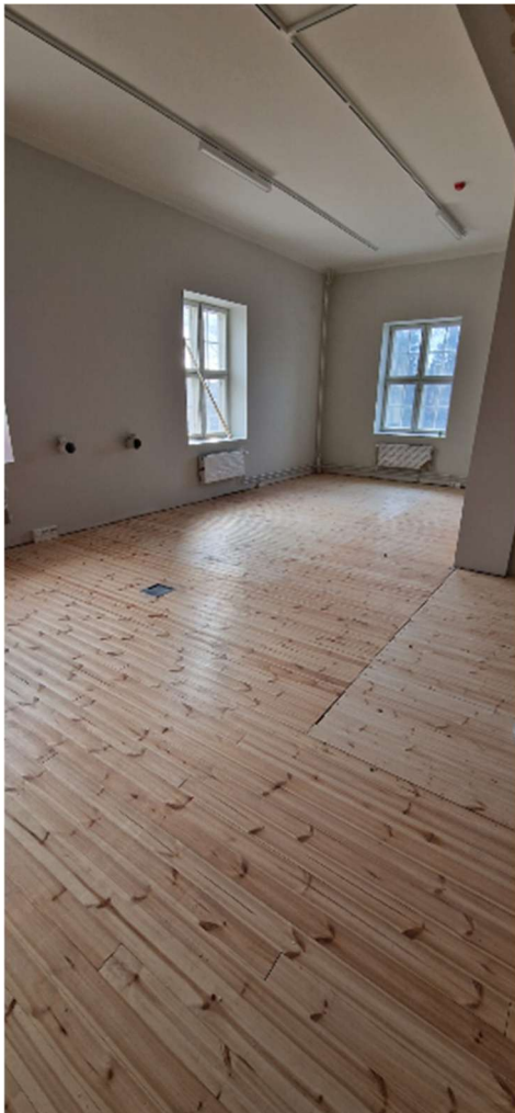
Lautalattiaa valmiina maalattavaksi toisen kerroksen näyttelytilassa.
