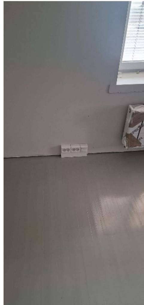
Pistorasioita asennettuna valmiiksi maalatulla lattialla. Seuraavana jalkalistojen asennusta.
