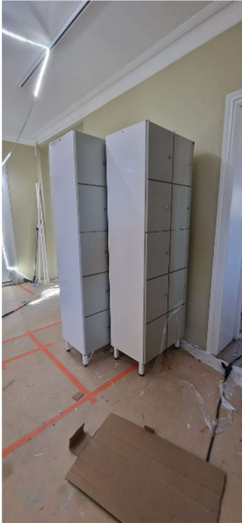
Lokero- ja pukukaapit on toimitettu työmaalle.
