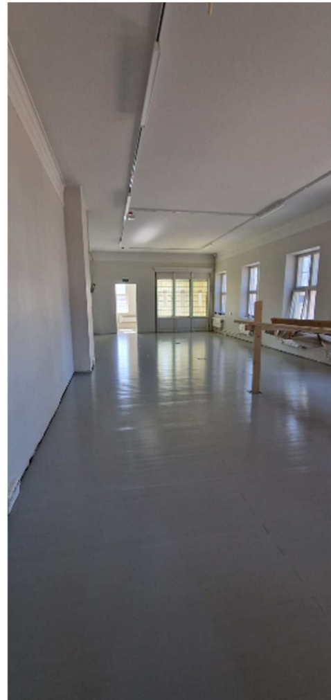
Viimeinen lautalattia on maalattuna. Seuraavaksi jalkalistojen asennusta.
