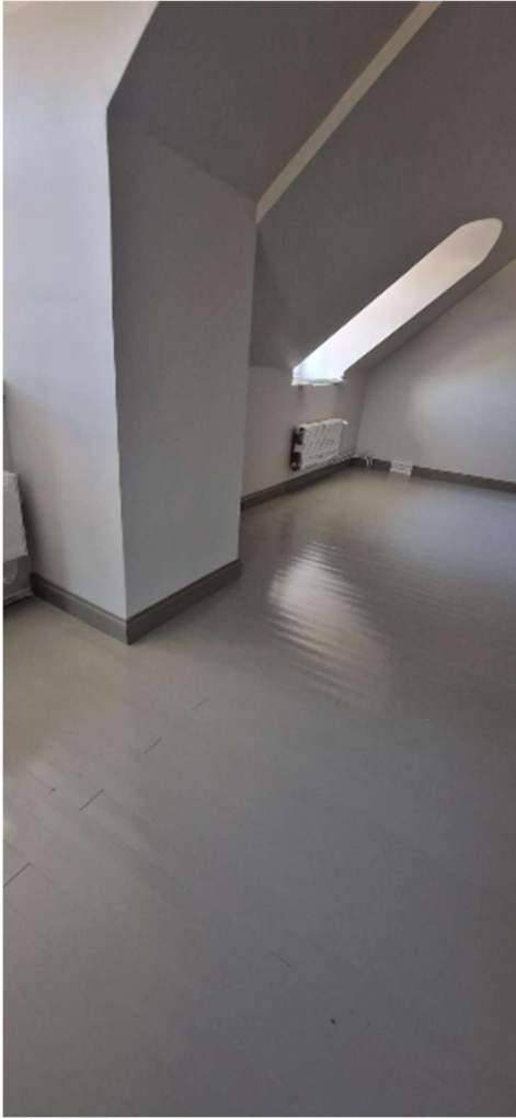
Jalkalistoja asennettuna 3. kerroksessa. Tiloihin tulee vanhanmallinen korkea puinen jalkalista.
