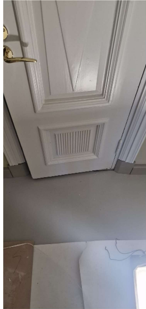
Ovien pieliin on asennettu jalkalistoituksen yhteydessä samanlaiset palikat jalka- ja ovilistan väliin, kuin oli aikaisemminkin ennen remonttia.
