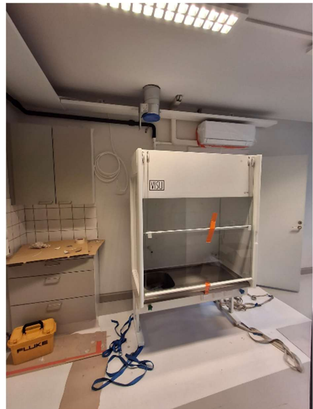
Vetokaappi on nostettu paikoilleen kolmanteen kerrokseen.
