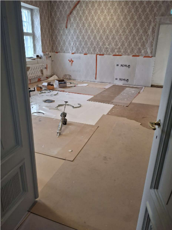
Parketti on suojattu ja jalkalistojen asennus käynnissä.
