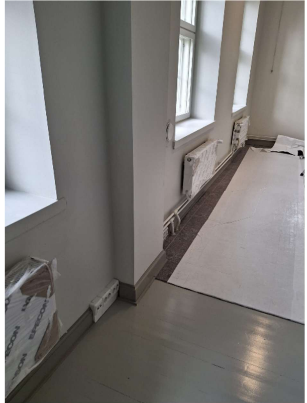
Jalkalistat ovat pääosin paikoillaan.
