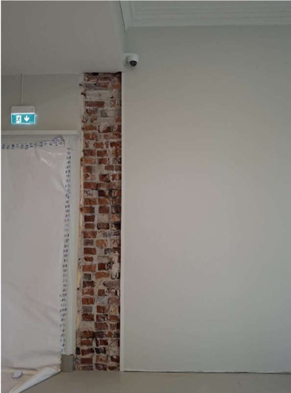
Pleksin asennus käynnissä näkyyn jäävän tiilimuurauksen peittämiseksi. Tiilimuuraukseen sumutettiin pölynsidonta-aine ennen asennusta.
