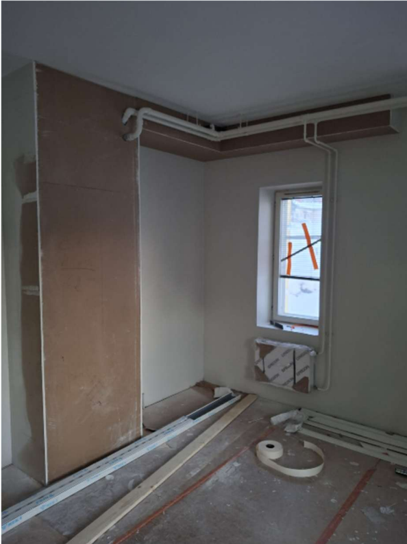
Tekniikkakotelot on rakennettu kipsilevystä, seuraavana tasoitukset ja maalaukset. Kyseisessä kotelossa kulkee vesiputkia ja ylemmän kerroksen wc-tilan viemäri.
