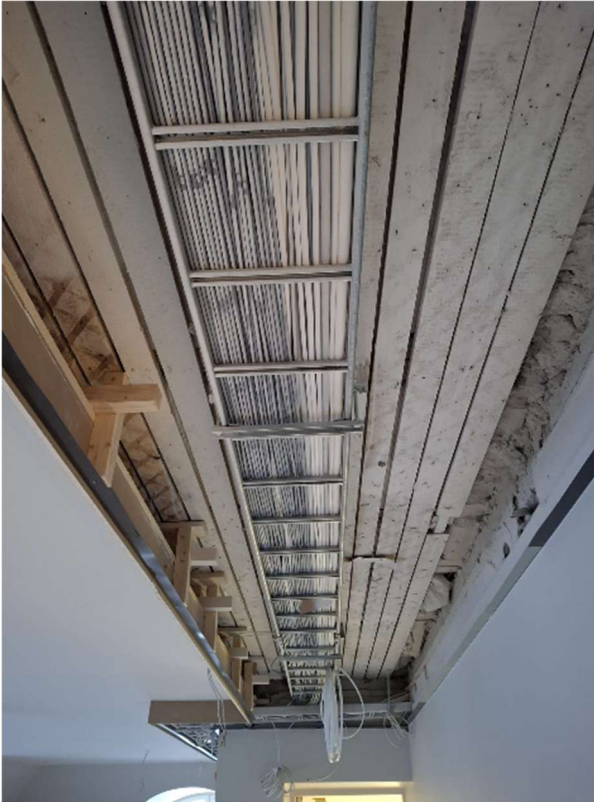
Kaapelien vetäminen on käynnissä.
