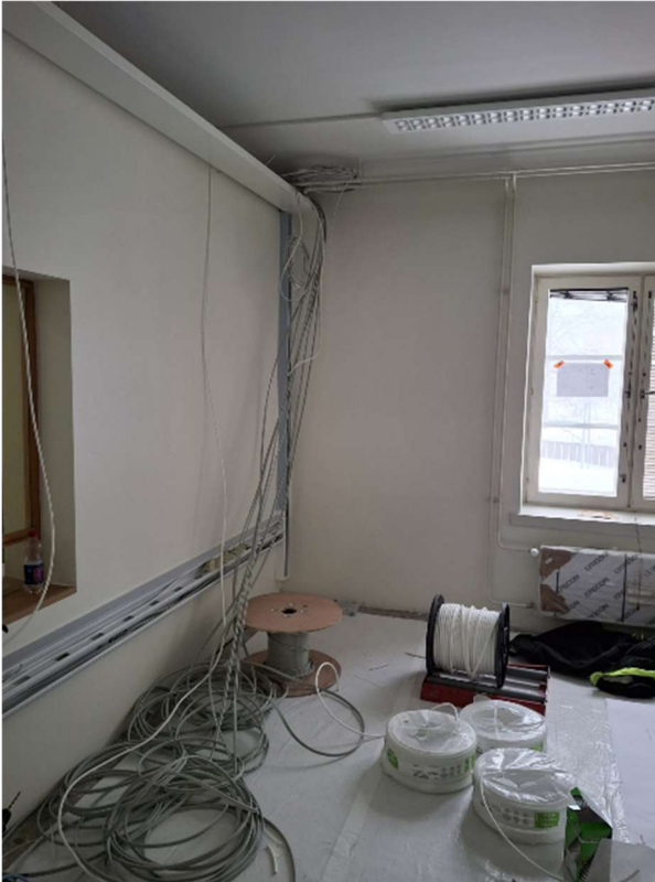
Kaapelin veto on työmaalla käynnissä.
