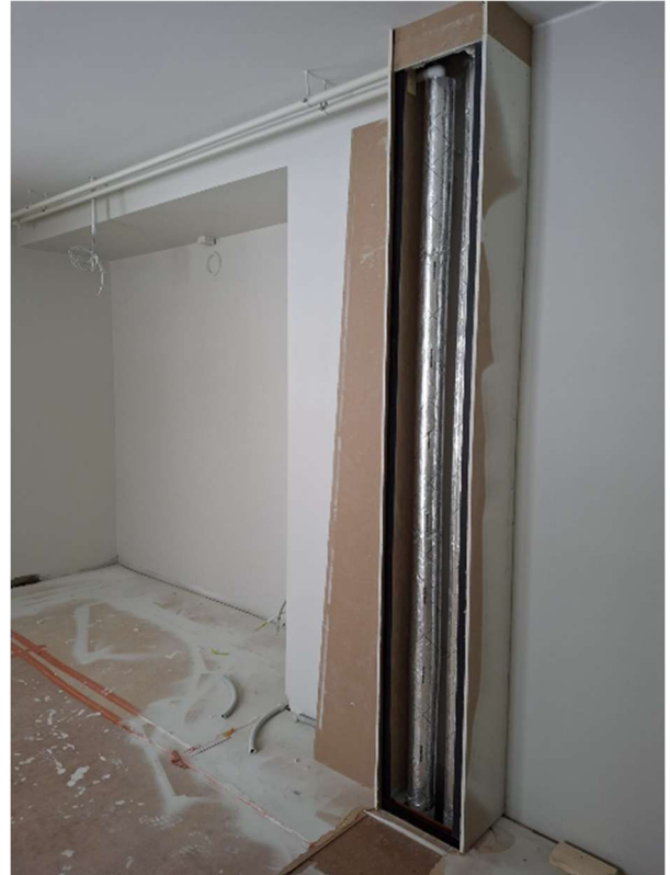
Lämmitysputkia on eristetty koteloissa. Koteloiden ummistus ja pintakäsittely jatkuu.
