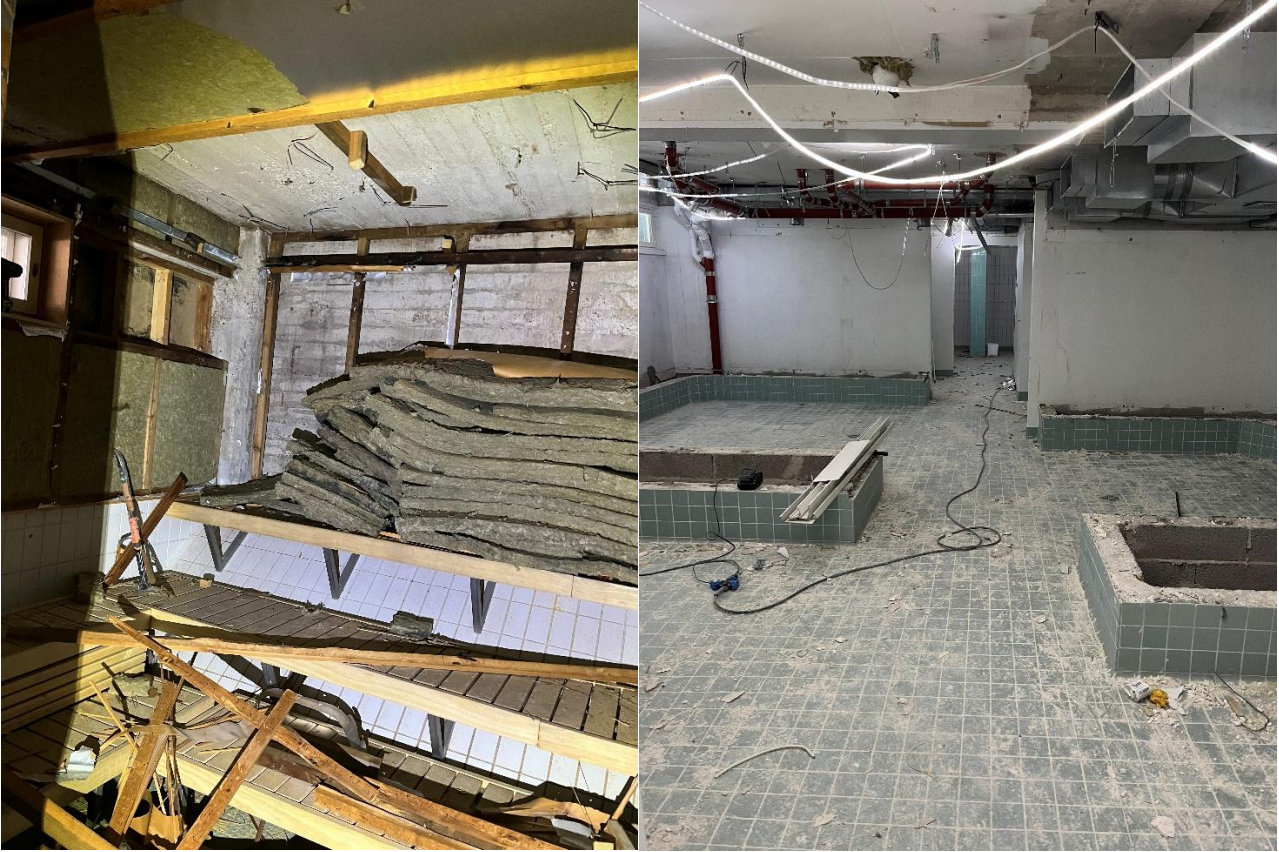
Sauna- ja pukuhuonetiloja purkuvaiheessa.
