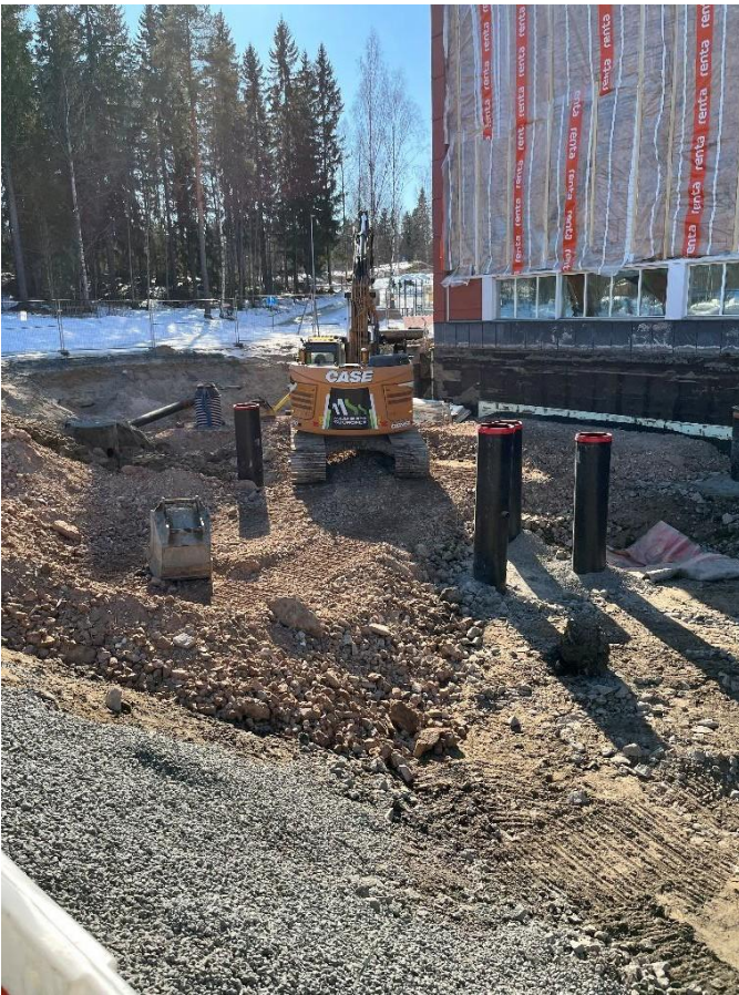
Pohjätäytöissä käytetään Asemakadun koulun betonimurskaa.
