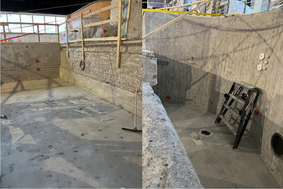
25m kuntoallas sekä hierontapiste laatoitus- ja vesieristyspurun jälkeen.
