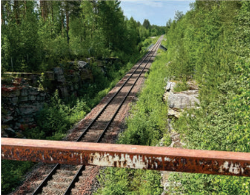
Kuva 25. Yleiskuva pohjavesialueella kulkevasta junaradasta.
