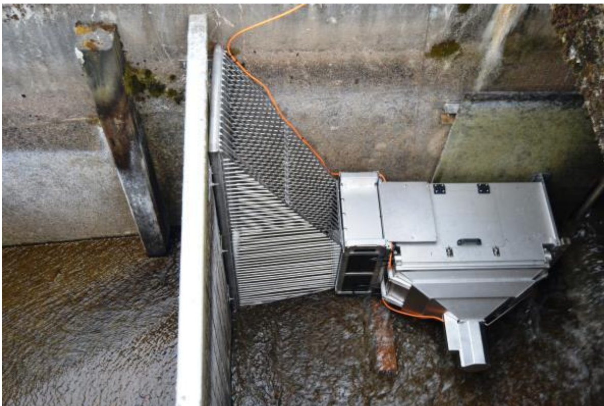
Laskurilaitteisto asennettuna ennen kalatien vesitystä.
