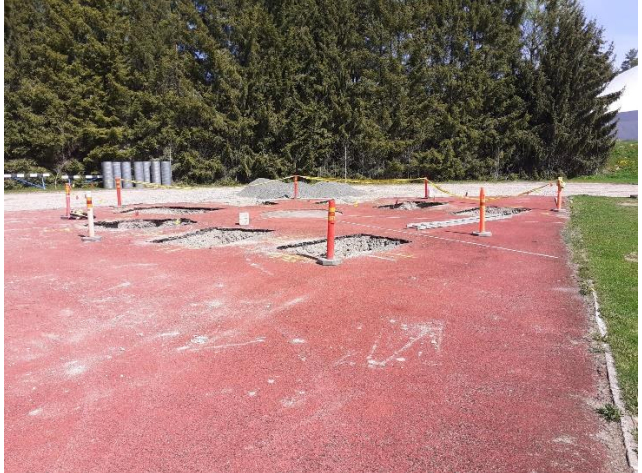
KUVA 3. Kuulantyöntöpaikan alustan tasausta.
