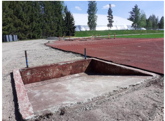
KUVA 2. Vesiesteen pinnoite ja aita poistettu.
